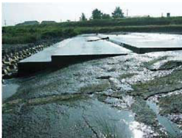
図 1.1.1 魚類の遡上・降下の阻害となっている横断工作物の例（高木井堰）
