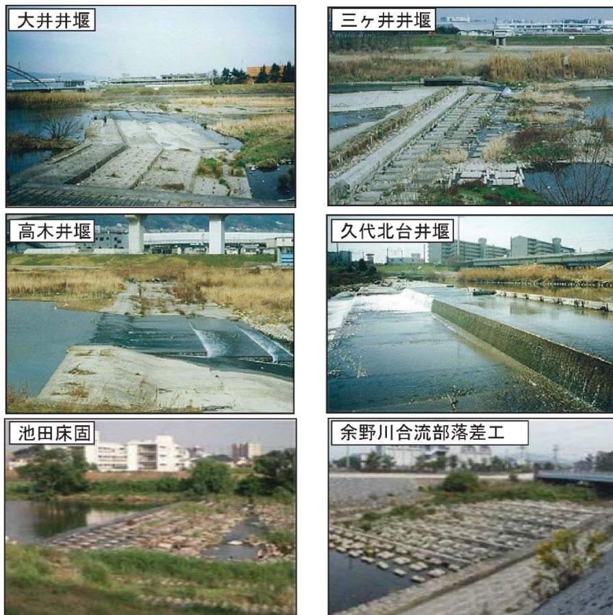
図 1.2.2 縦断方向の連続性を阻害している井堰
