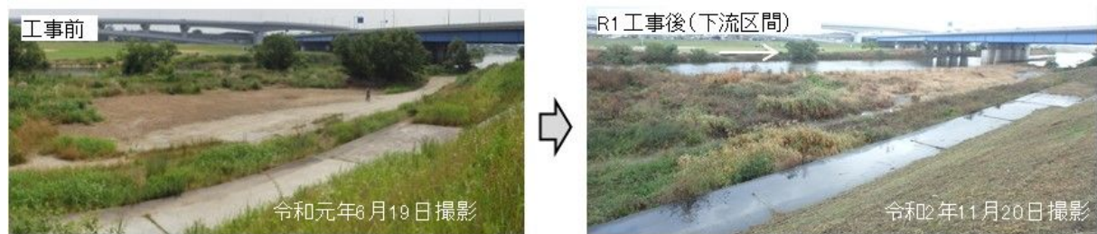
図 2.3.9 自然再生事業の実施箇所（猪名川大橋地区）
