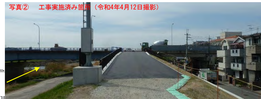
現地状況 堤防拡幅箇所
