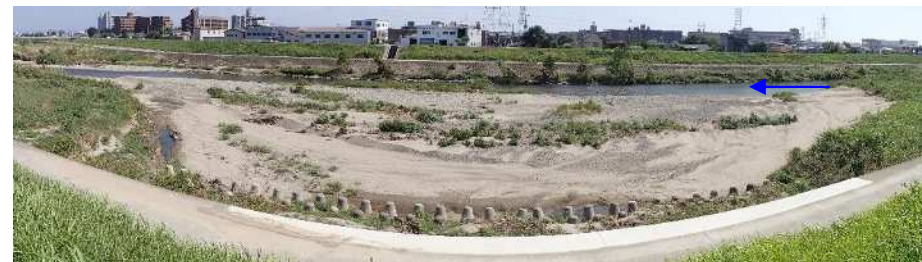
写真 現地状況 出水後(平成30年8月)
