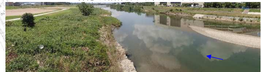
写真② 下流側現地状況 出水後(平成30年8月)
