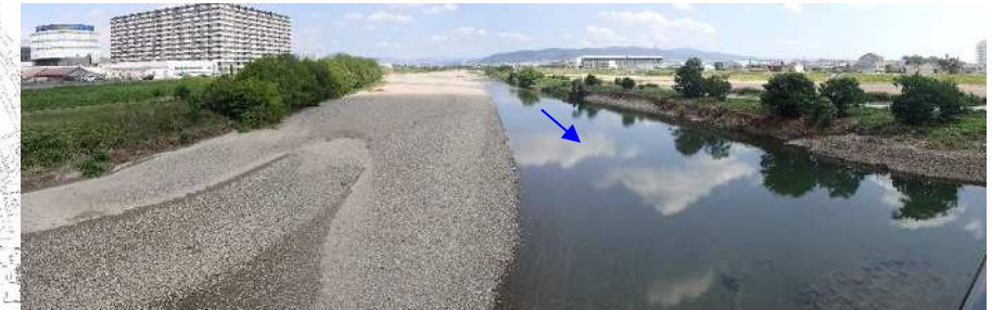
写真④ 上流側現地状況 出水後(平成30年8月)
