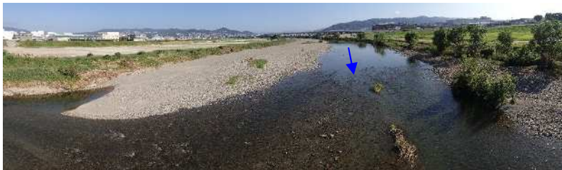
写真 上流側現地状況 出水後(平成30年8月)
