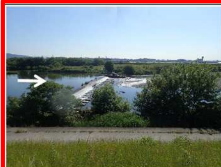
三ヶ井井堰(猪名川7.2km付近)
