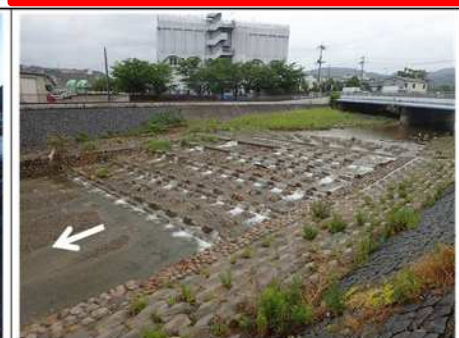
加茂井堰(猪名川12.3km付近)
