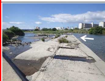
久代北台井堰(猪名川9.7km付近)
