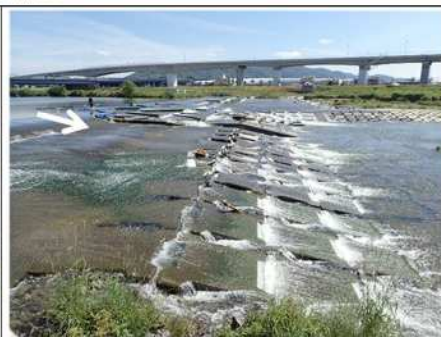
高木井堰(猪名川8.8km付近)
