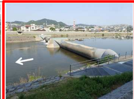
加茂井堰(猪名川11.9km付近)
