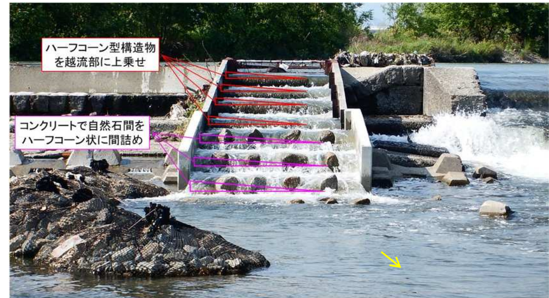
三ヶ井井堰簡易魚道の追加改良案(全体のイメージ)
