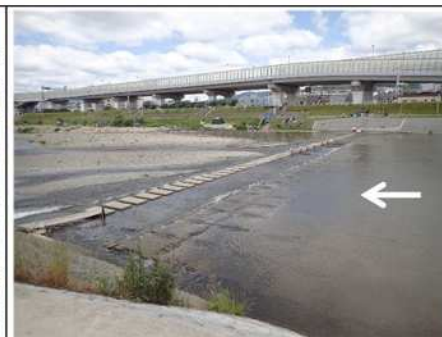
池田床固(猪名川10.4km付近)
