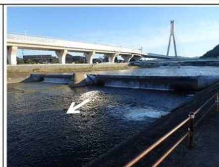
池田井堰(猪名川11.0km付近)
