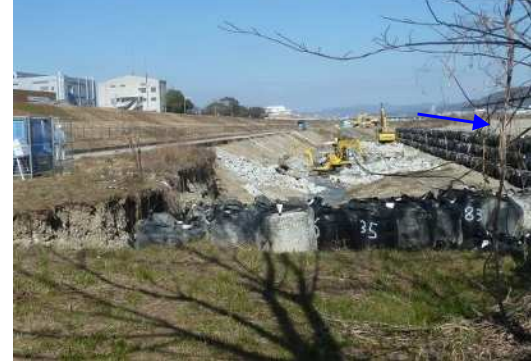
写真③ 工事実施状況 右岸から上流河道を望む (平成31年2月撮影)
