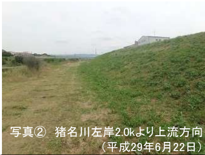
写真② 猪名川左岸2.0kより上流方向 (平成29年6月22日) 高水敷、堤防法面にはセイバンモロコシ、ムラサキツメクサ等が生育
