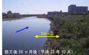
河原再生試験施工地 (H19.3施工)
