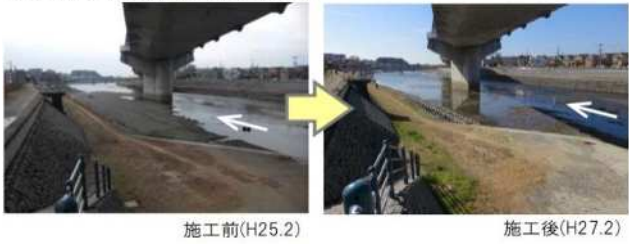
【施工前後写真(猪名川 11.3k 付近)】
