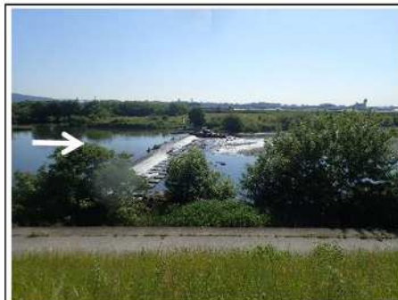
三ヶ井井堰(猪名川7.2km付近)
