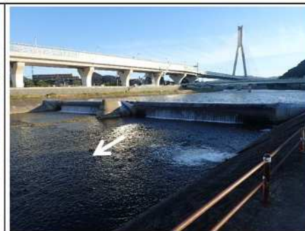
池田井堰(猪名川11.0km付近)
