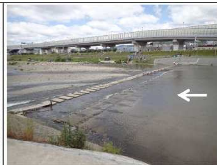
池田床固(猪名川10.4km付近)
