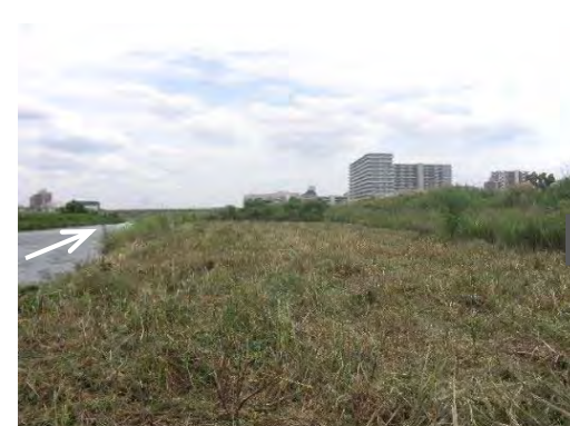
施工前[猪名川 6.8k 付近右岸] (H25.7)
