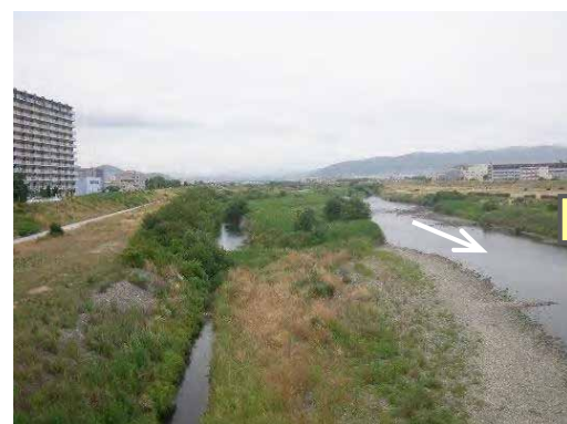
施工前[桑津橋上流 6.4k 付近] (H25.6)
