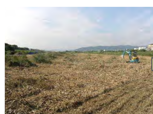
施工前[猪名川 6.9k 付近右岸] (H25.7)
