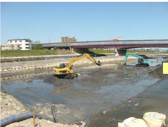
施工中[名神猪名川橋下流 1.4k 付近]（H25.5）
