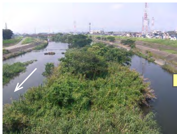
施工前[新南園橋上流 2.4k 付近] (H24. 7)
