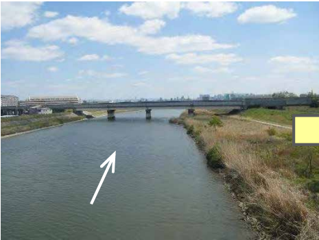
施工前[東園田橋下流 0.6k 付近]（H25. 4）
