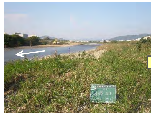
施工前[猪名川 6.2k 付近左岸] (H25.11)
