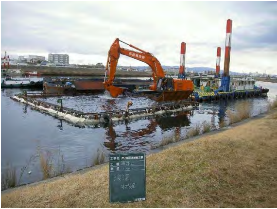
施工中[汚濁防止対策実施状況] (H25. 1)
