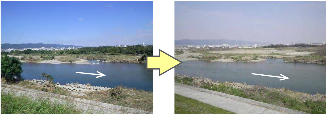
施工前[猪名川 7.2k 付近] (H25. 10)
