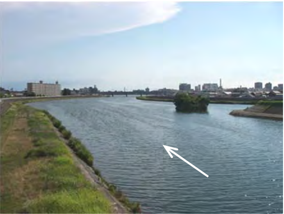
施工前[戸ノ内橋下流 0.6k 付近] (H24. 7)
