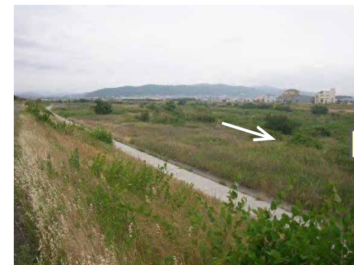
施工前[猪名川 6.6k 付近右岸] (H25.6)
