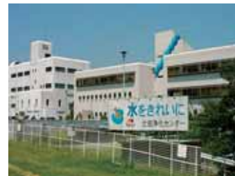
尼崎市北部浄化センター
