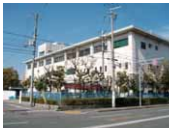
尼崎市栗山中継ポンプ場
