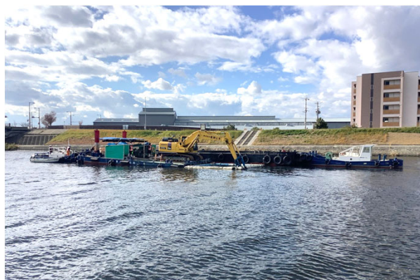
戸ノ内地区河道掘削（国土交通省）
