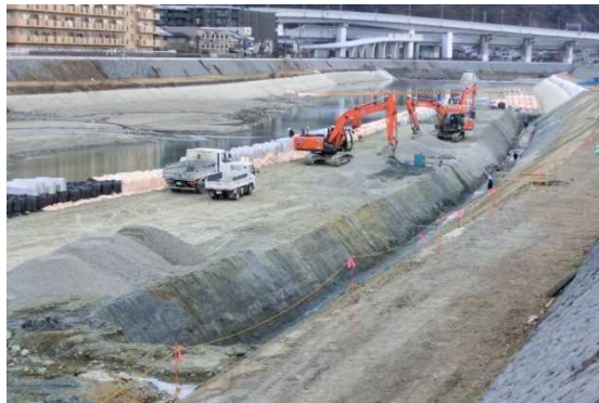
出在家地区河道掘削(国土交通省)
