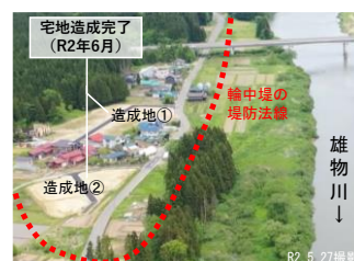
移転先宅地造成完了状況
