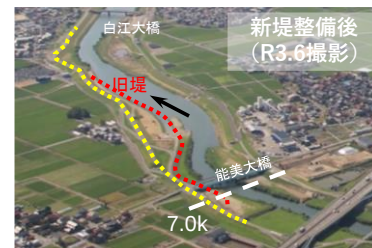
引堤(石川県梯川水系梯川)
