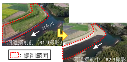
河道掘削(鹿児島県内川水系羽月川)
