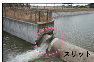
▲スリットの設置状況
