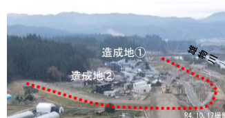
移転家屋の建設が進む状況
