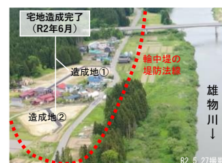
移転先宅地造成完了状況
