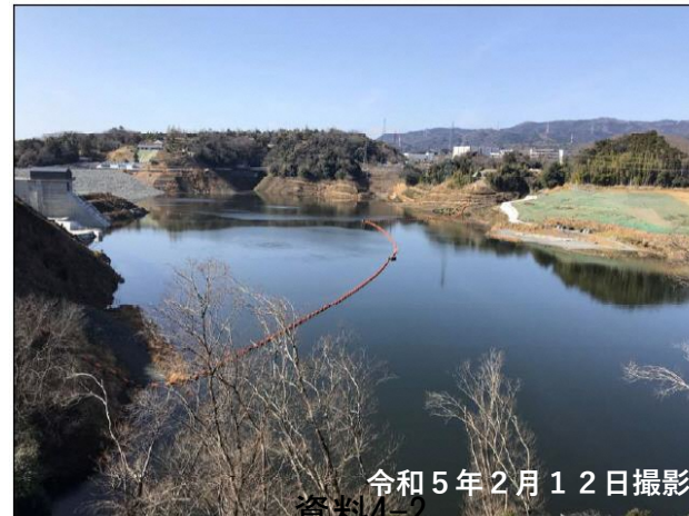
左岸上流より貯水池周辺法面を撮影 (定点②)
