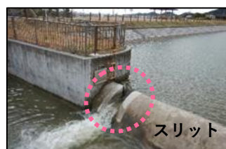
▲スリットの設置状況
