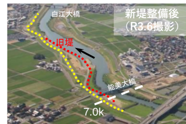
引堤(石川県梯川水系梯川)
