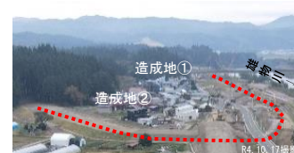
移転家屋の建設が進む状況
