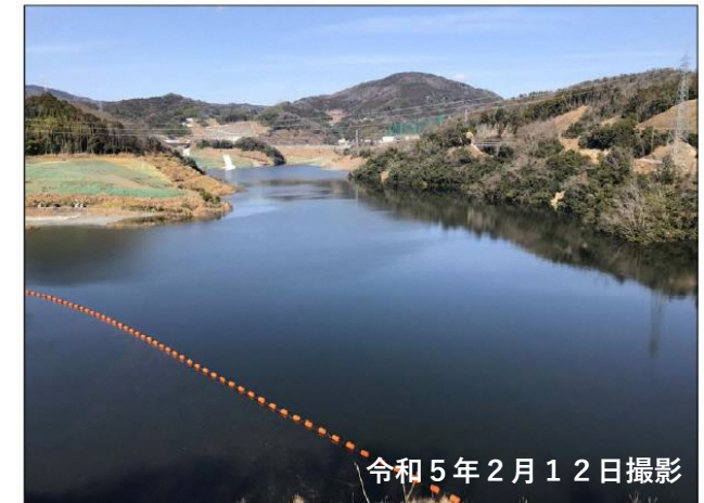
左岸上流より貯水池周辺法面を撮影 (定点③)
