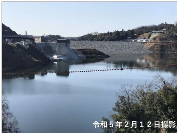
左岸上流より堤体上流面を撮影 (定点①)
