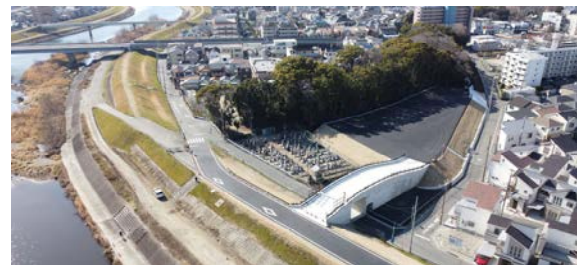
防災活動拠点整備後
