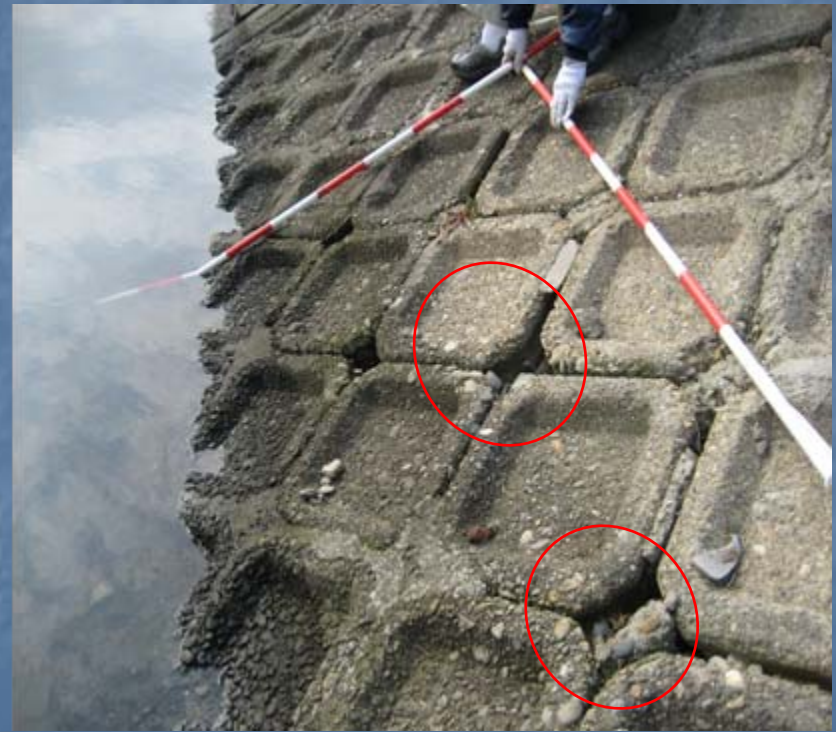
低水護岸老朽化(目地隙間) (猪名川右岸1.0km付近)
