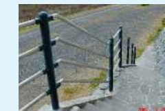
手すり付階段工
