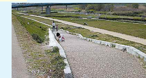
緩傾斜坂路(占用・伊丹市)
