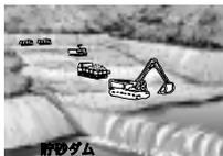
土砂を貯砂ダムによってダム湖に流れ込む前に貯めた後、取り除きます。
