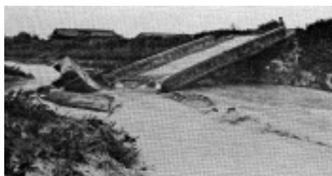
千里川 下走井橋被害状況
