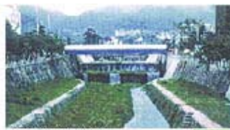
床止め(落差工)
