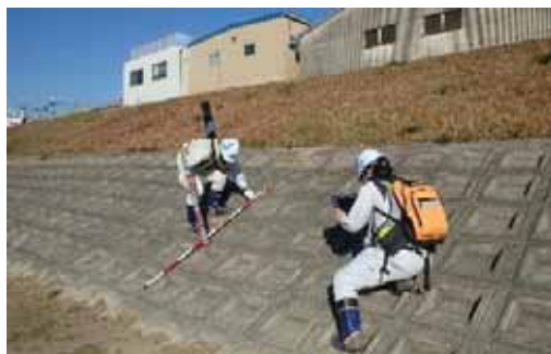
▲護岸のひび割れを点検
