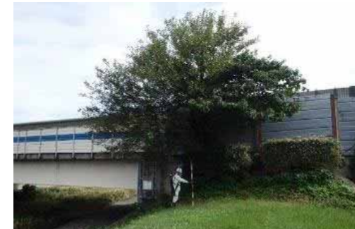
▲樹木の繁茂状況を点検
