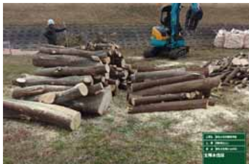
樹木伐採施工状況
