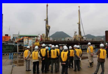
【岸壁より施工中の現場見学】
