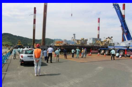
【艀装中の作業台船の見学】
