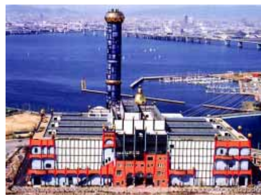
大阪市舞洲スラッジセンター の写真
