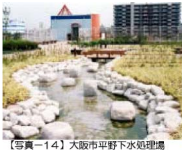
【写真-14】大阪市平野下水処理場
