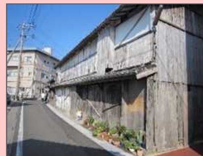
空き家の除却
