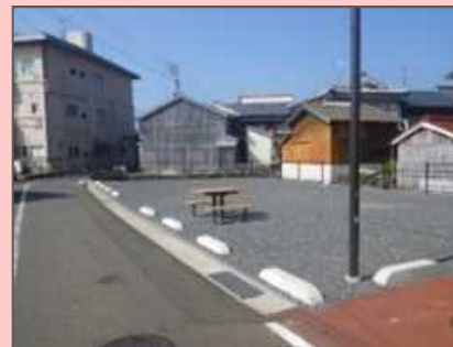
居住環境の整備改善のため、 空き家を除却
