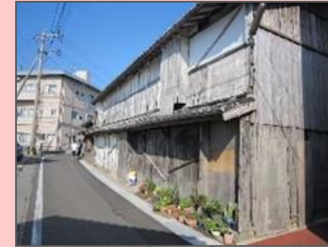
空き家の除却
