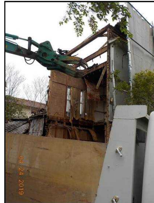
H31年4月24日 除却工事中
