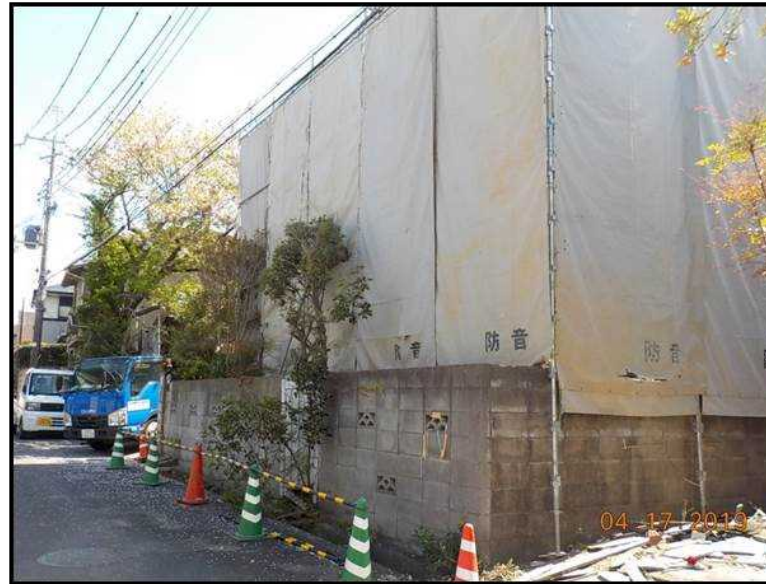
H31年4月17日 除却工事着手
