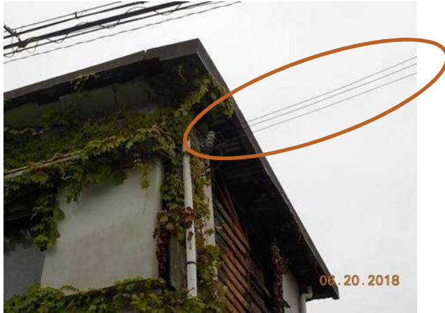
H30年6月20日 関電引込線撤去依頼
