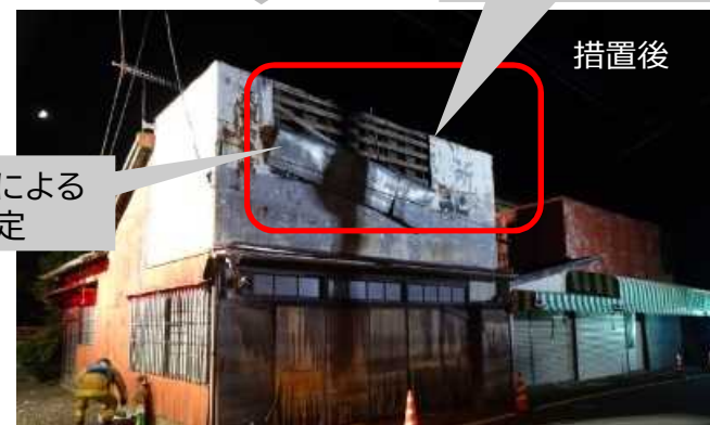
外壁の一部切断
