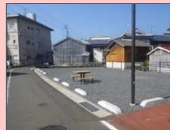
居住環境の整備改善のため、 空き家・不良住宅を除却
