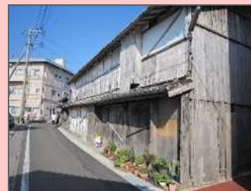
空き家の除却
