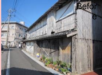
空き家の除却
