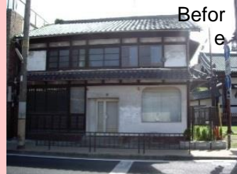
空き家の活用
