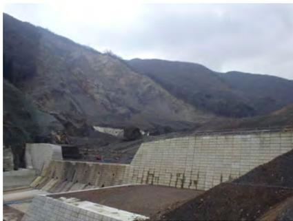
図-6 崩壊地脚部の堰堤工（赤谷地区）
