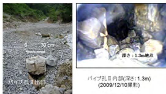
写真-4 溪床堆積物の一部再移動(2008年10月24日の豪雨)によって露出したパイプ孔Ⅱの出口と内部の状況
