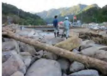
支川からの土石流により本川では大きい粒径の石により河道が阻害される。
