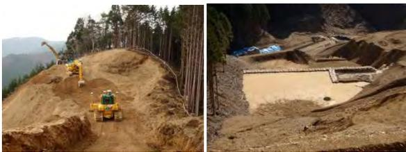
図-5 崩壊地頭部の排土（無人化施工）と崩壊地からの土砂流出抑制工（北股地区）
