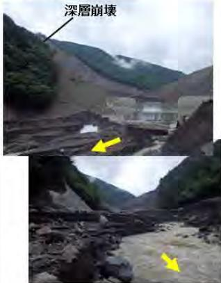
深層崩壊からの再崩壊はない。崩壊土砂ならびに河道閉塞土砂の一部が下流に流出するが、堰堤工によって捕捉されるとともに、河道閉塞の侵食が抑制されている。
