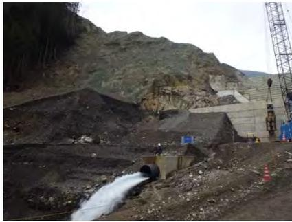
図-4 暗渠排水管による安定的な排水（赤谷地区）
