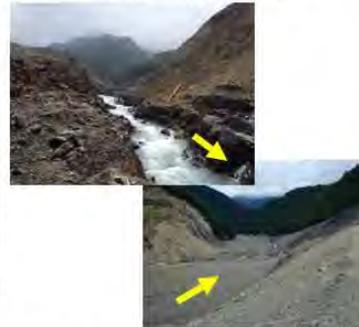
平成26年台風11号によって河道閉塞部に形成された侵食流路の再侵食と土砂流出が発生。
