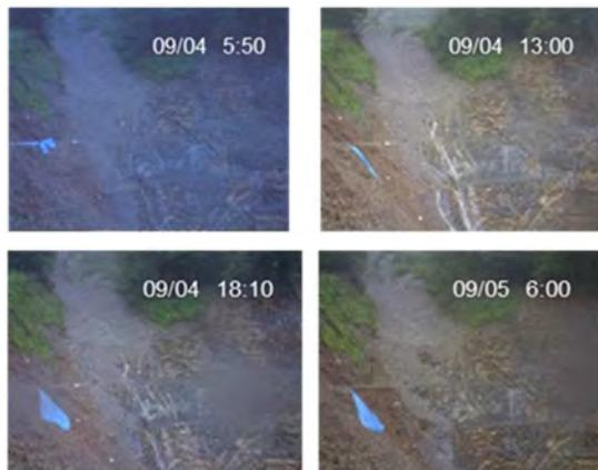
写真-6 床固工上流でのパイプ孔からの伏流水排出状況（2011年9月4日）
