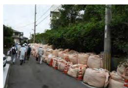
写真-2 斜面下部の応急対策状況
