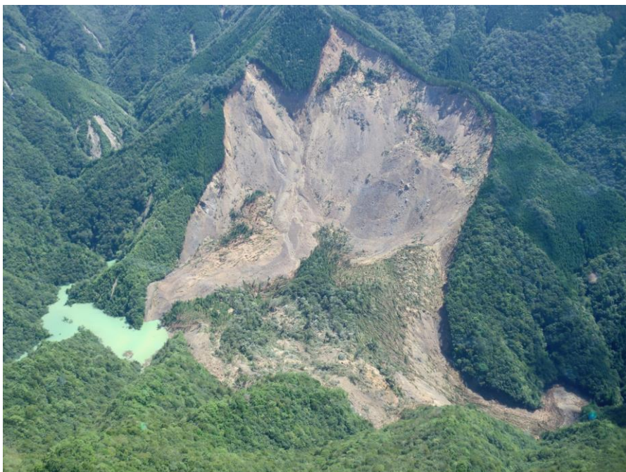
奈良県十津川村栗平地区の深層崩壊と河道閉塞(2022/9/6, 国土交通省)
