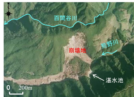
図-1 熊野地区被災状況
