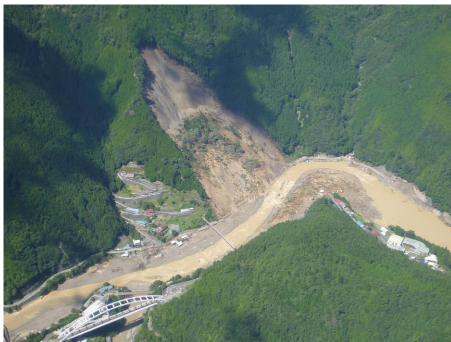
奈良県十津川村宇井地区の深層崩壊と河道閉塞の越流決壊(2022/9/6, 国土交通省)
