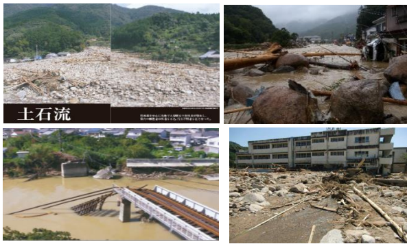
写真-1 那智勝浦町における紀伊半島大水害の発生状況 (平成 23 年 紀伊半島大水害記録 和歌山県より)
