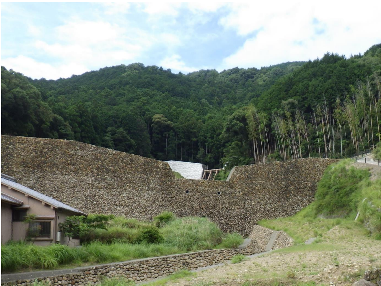
図-3 那智川流域鳴子谷川の修景工を施した1号砂防堰堤
