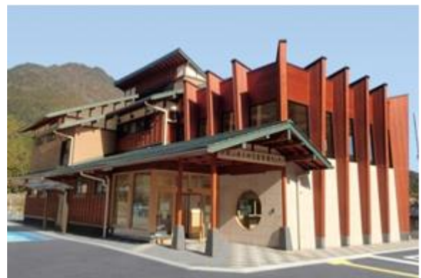
写真-1 和歌山県土砂災害啓発センター外観
