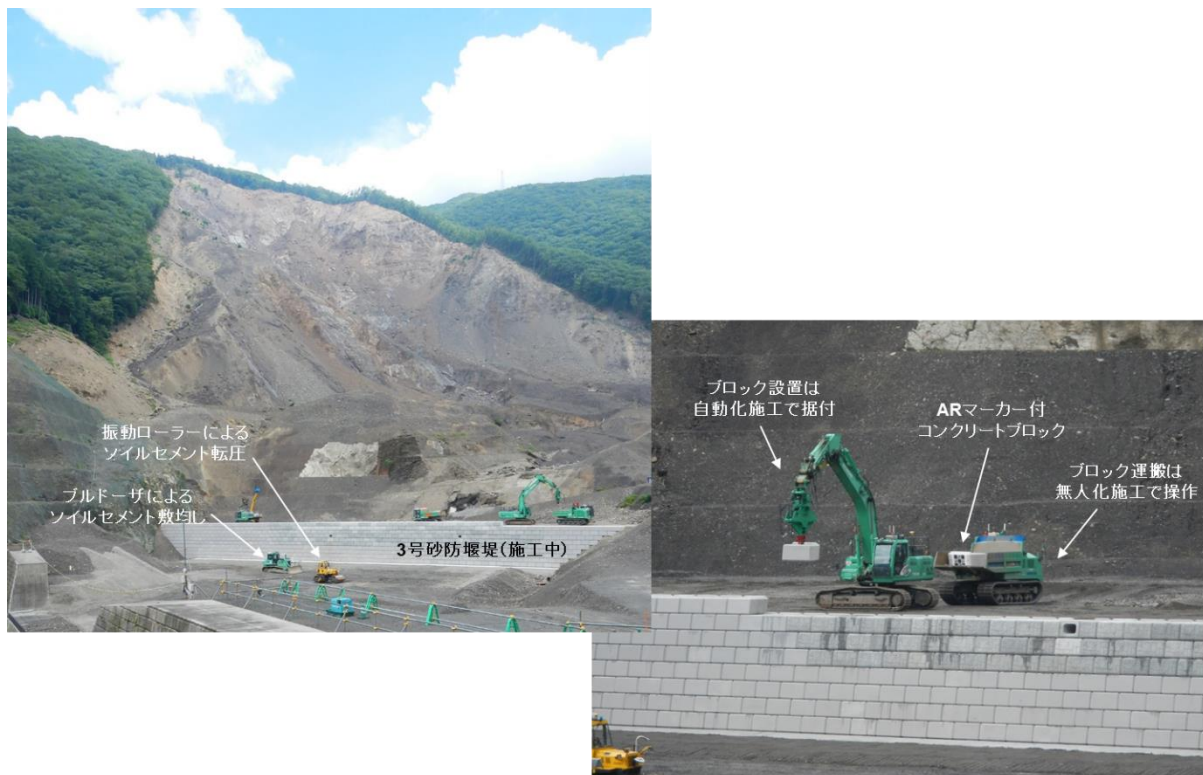
図-4 奈良県五條市赤谷地区における自動化技術を用いた3号砂防堰堤の施工
