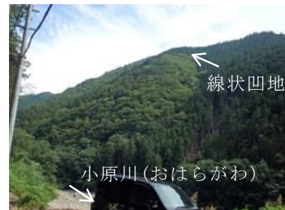
写真-1 奈良県十津川村での変形斜面(岩盤クリープ斜面)の事例
