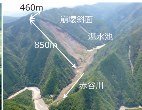
赤谷地区(崩壊2日後)
