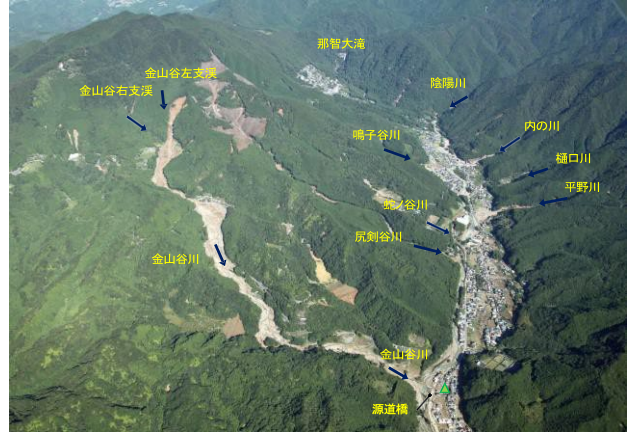
図-1 那智川流域被災状況
