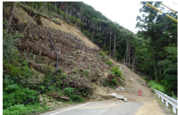
写真-3 災害現場
