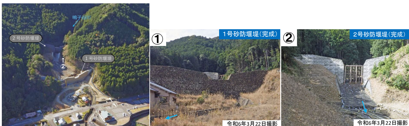
図-5 鳴子谷川における砂防堰堤の整備状況
