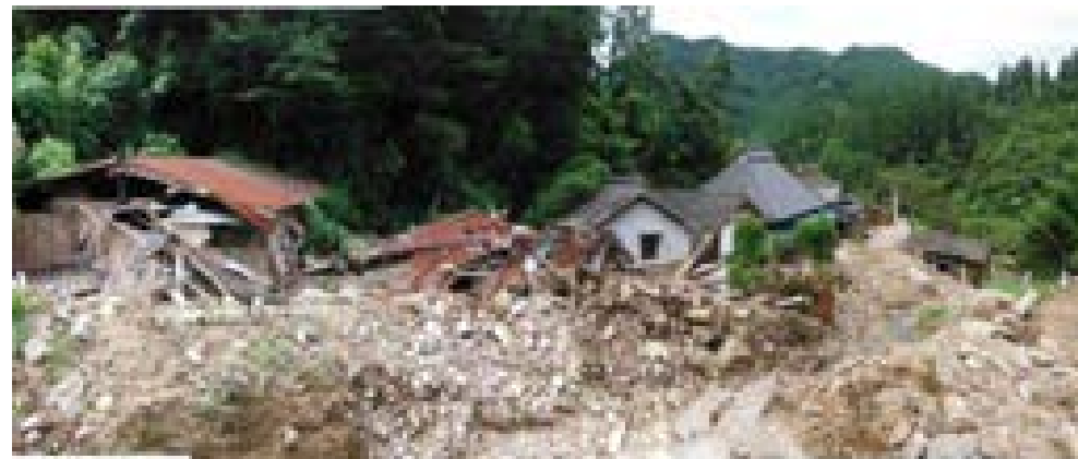
土石流による土砂の氾濫と家屋等の被害
