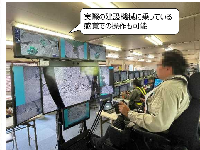
無人化施工の様子(赤谷地区)
