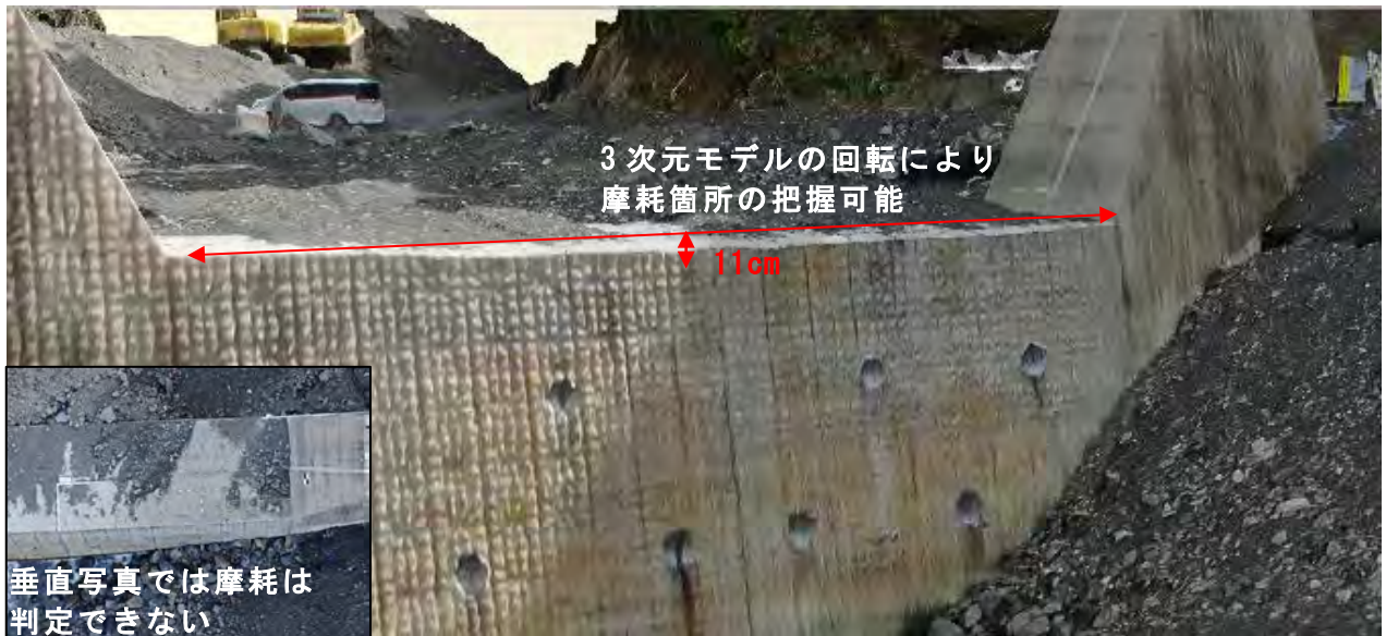
(b) 堰堤天端摩耗 拡大
