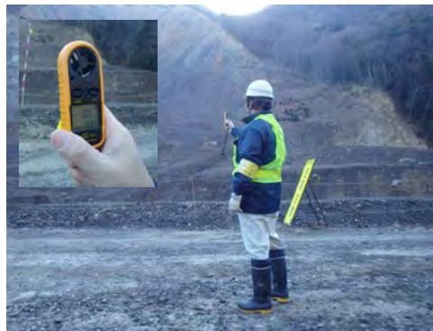
図 2.4-1 現場での地上風速の確認事例
