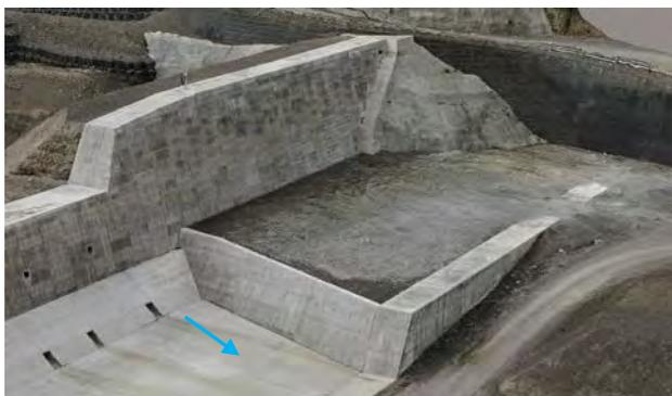
写真No.8 左岸袖、側壁護岸(3次元モデル)
