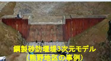
鋼製砂防堰堤3次元モデル (熊野地区の事例)
