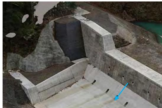
写真No.9 右岸袖、側壁護岸(3次元モデル)
