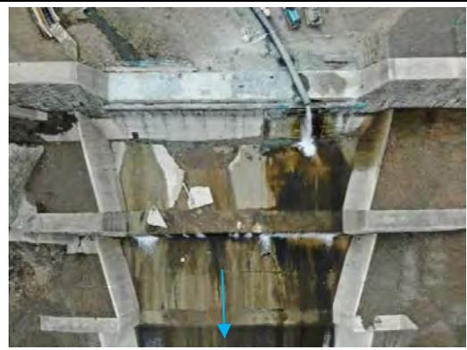
写真No.6 堰堤水叩き、水通し
