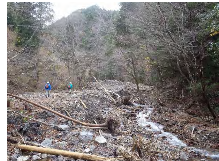
河道閉塞下流河道の状況(2011/12/9)
