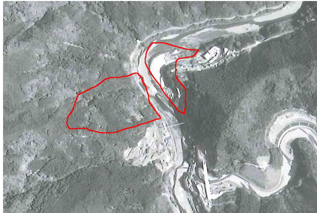
宇井地区 崩壊発生前の状況(2004/5/8)
