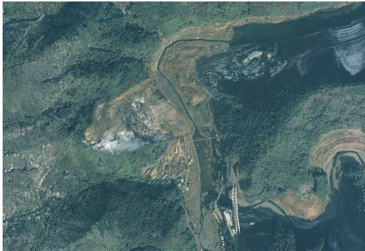
宇井地区 崩壊発生後の状況(2012/2/5)
