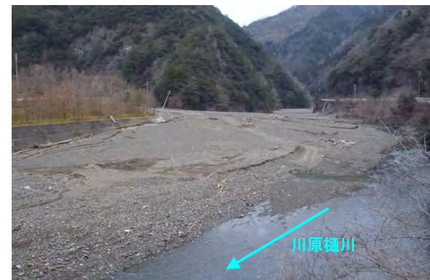
川原樋川合流点の状況(2012/2/21)
