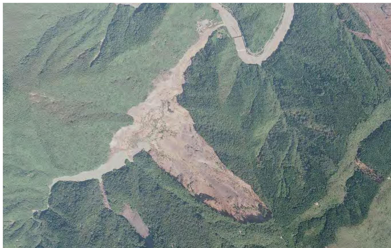
赤谷地区 崩壊発生後の状況(2011/9/7)
