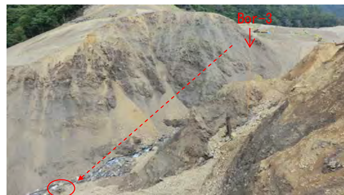
図-1.2.12 ボーリング機械（Bor-3）落下状況
