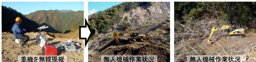
滑落崖に近接する箇所の排土整形無人化施工の実施(北股地区の例)
