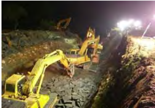
仮排水路掘削イメージ(他事例)
