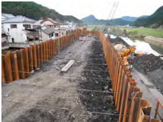
鋼矢板二重締め切りの中詰め状況
