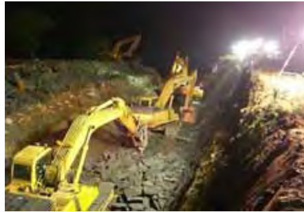
仮排水路掘削イメージ(他事例)
