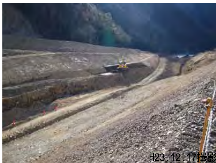
仮排水路工掘削、法面整形状況
