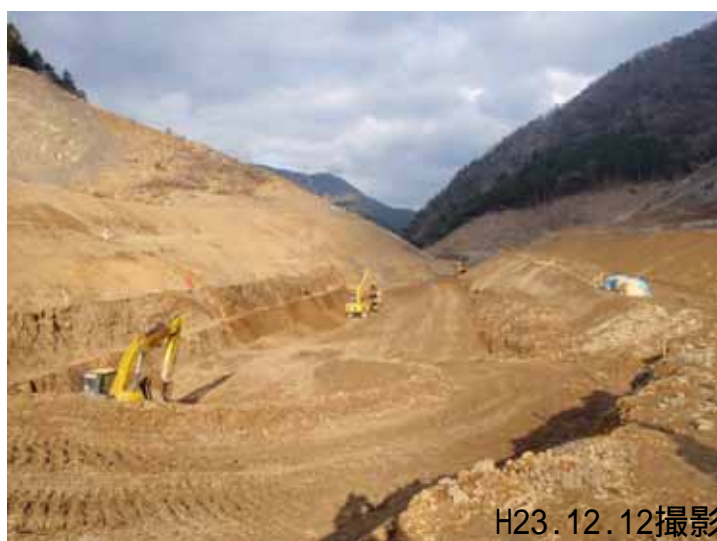
仮排水路工掘削、法面整形状況
