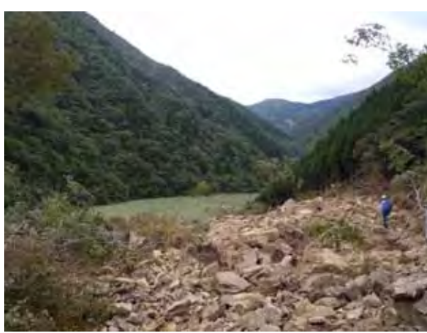
堰止め湖面を崩壊土砂上部よりのぞむ
