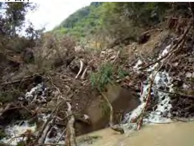
河道閉塞の末端部からしみ出る水の状況
