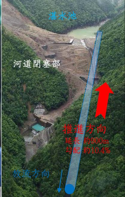
河道閉塞で発生した湛水池5地区の内、4地区は解消させました。現在、最後の湛水池の水を抜くため、排水トンネルを整備していますが、長殿谷の地盤は大変硬く、延長が約900mと大変長い。また10.4%と急勾配という厳しい条件下で掘り進めていけないといけません。紀伊山系砂防事務所では、それらの条件下でも施工可能なCMT工法(複合推進工法)で過去例にない厳しい条件下で排水トンネル整備工事を実施しています。
