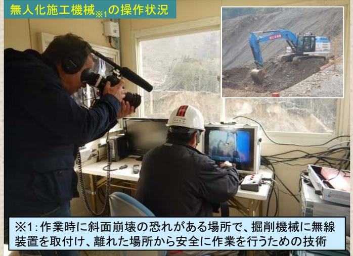
※1: 作業時に斜面崩壊の恐れがある場所で、掘削機械に無線装置を取付け、離れた場所から安全に作業を行うための技術
