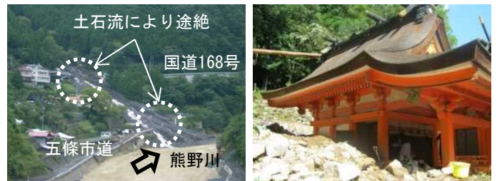
土石流による交通途絶、孤立集落の発生
