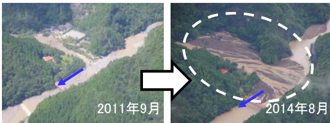
赤谷川、川原樋川合流地点（五條市）での土砂堆積状況
